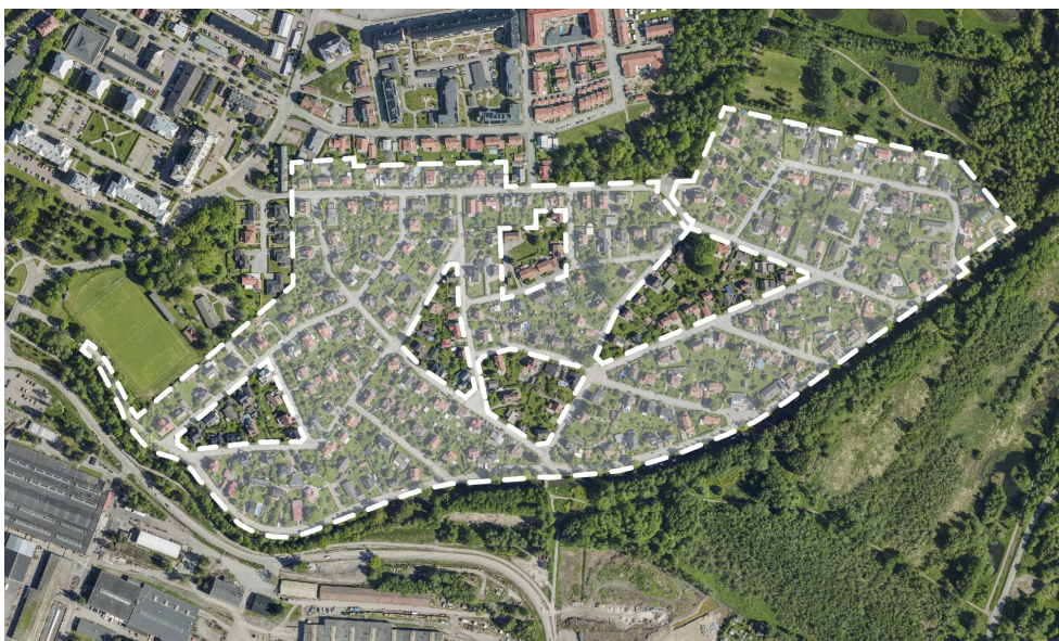
Bild som illustrerar planområdes avgränsning. Plangräns är markerad med vit streckad linje.
