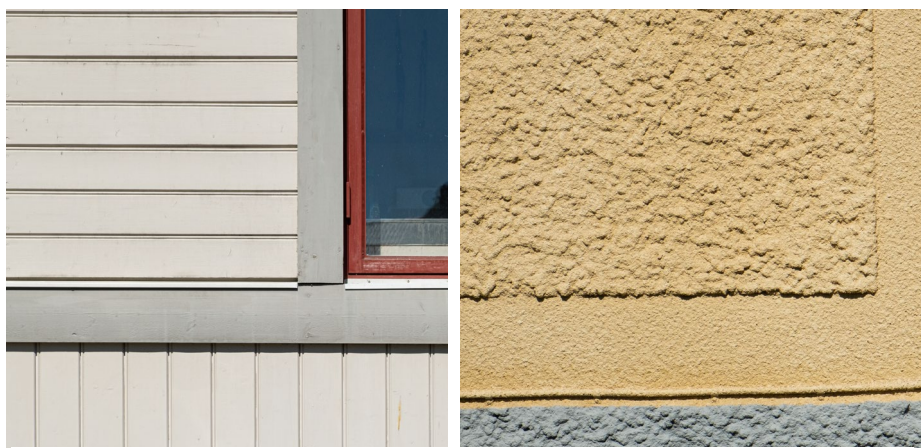
Utformning. Exempel på typiska fasadmaterial, fasadkulörer och detaljering från området. Målad liggande och stående träpanel. Listverk och fönster lyfts fram med mörkare kulörer (t.v.). Putsfasad i ljus kulör. Olika grovhet i putsen lyfter fram fasadens detaljer (t.h.)
