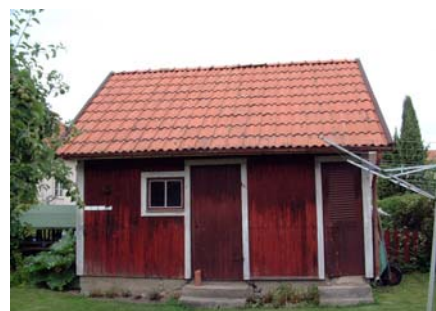
Ett av de många av uthusen som finns kvar. Kronovägen 11, Valand 9
