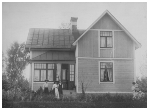
Exempel på en L-formad byggnadskropp med glasat entréparti och liggande och stående spontad panel., sadeltak, Krokvägen 23, Mimer 3.
