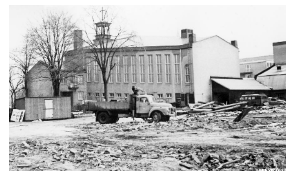
Överst: 1901. Så när som på den breddade Västra vägen/ Östra Bangatan har kvarteret och de omliggande omgivningarna fått den struktur som i huvudsak bevaras än i dag. Källa: Lantmäteriet Nedan; Rivningar inför breddandet av Västra gatan/ Östra Bangatan. Föregångaren till dagens Pingstkyrka i fonden. Källa: Örebro stadsarkiv
