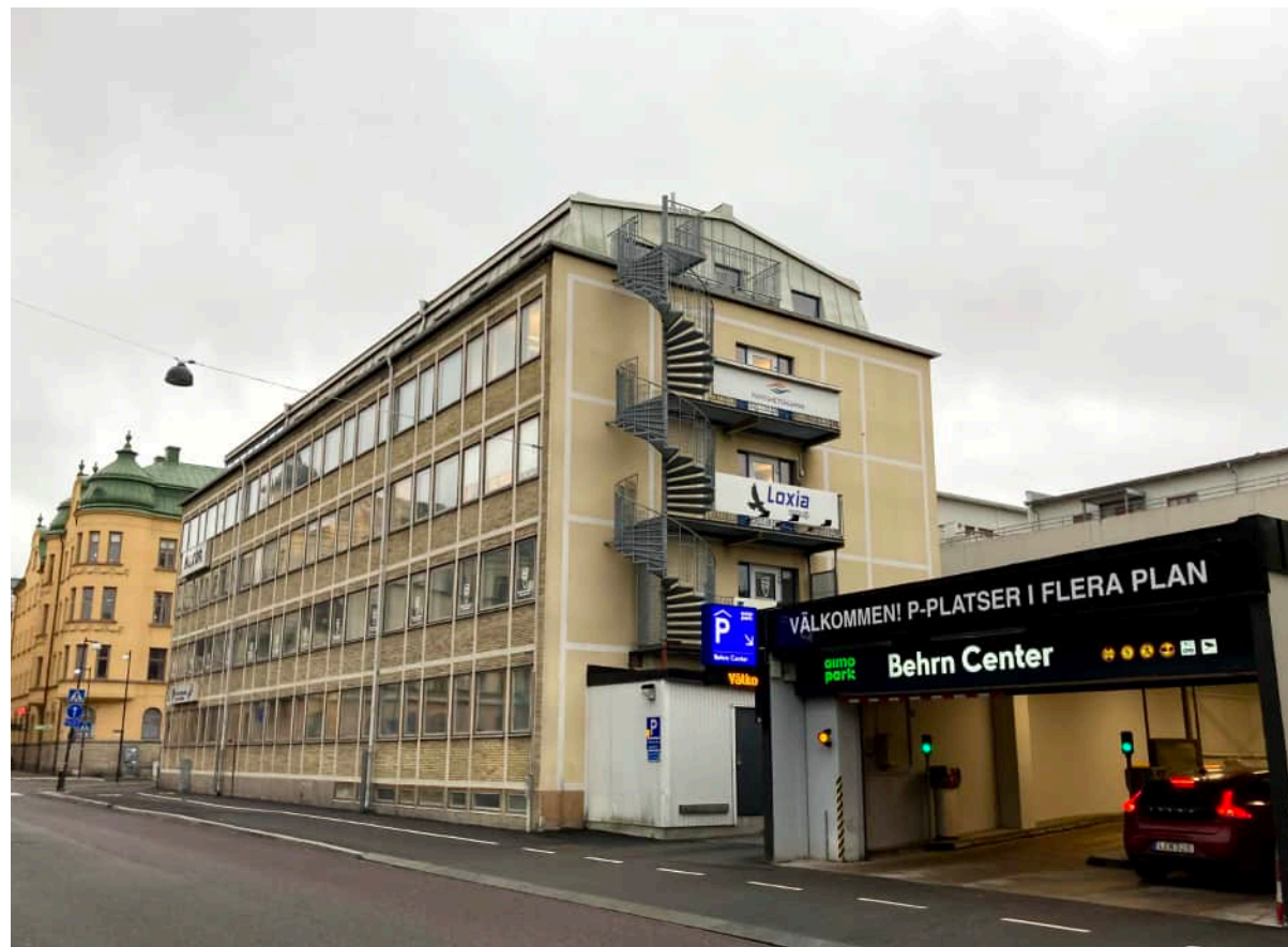
Påbyggnaden från 1980-talet har ett flackt sadeltak svagt lutande fasader och bryter därmed mot byggnadens ursprungliga volymhantering som byggd på enkla geometrier med två vinkelställda rätblock.
