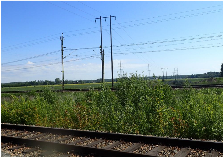
Figur 32 Ledningar över området.
