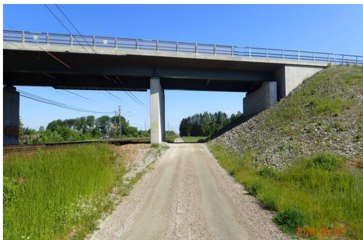
Figur 29 Vägbro över järnvägen.
