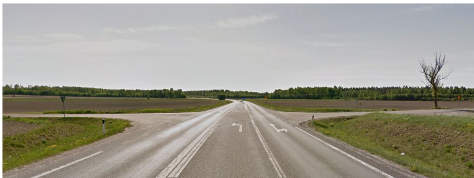
Korsningen mellan riksväg 51 och väg 683. Bilden är tagen på riksväg 51 blickande österut
