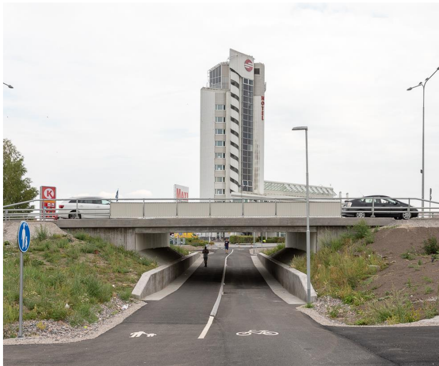
Figur 5. Barriärbryggande passage genom gång- och cykelbana under Hedgatan, Örebro.
