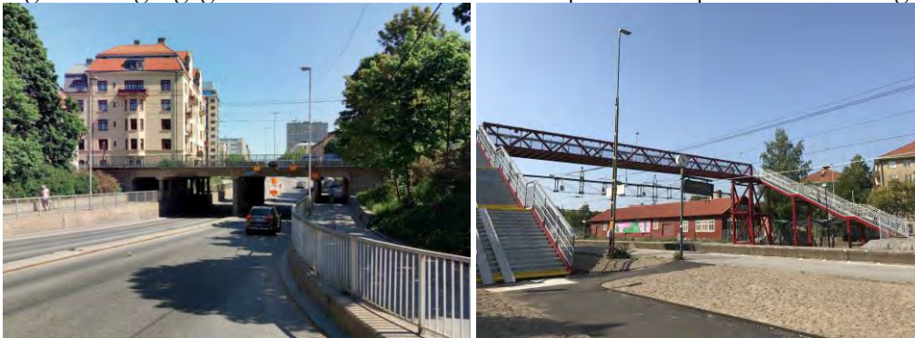
Figur 8. Passager över/under järnvägen, tv. Hagatunnelns smala GC-banor, th. gångbro vid stationen.
