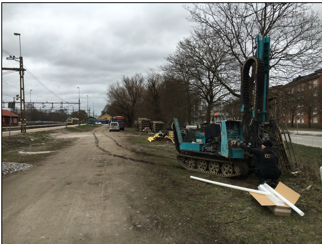
Foto 5.2. Foto från aktuellt undersökningsområde. Plats för installation av grundvattenrör GV4.
