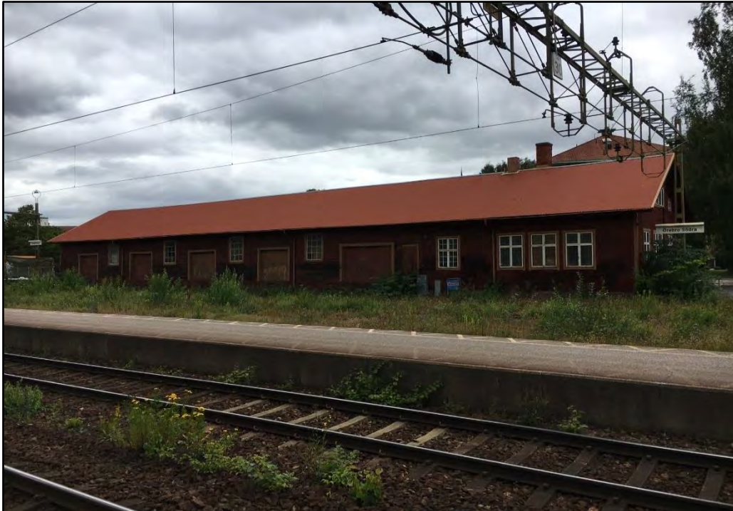
Foto 3. Södra station, äldre magasinsbyggnad.
