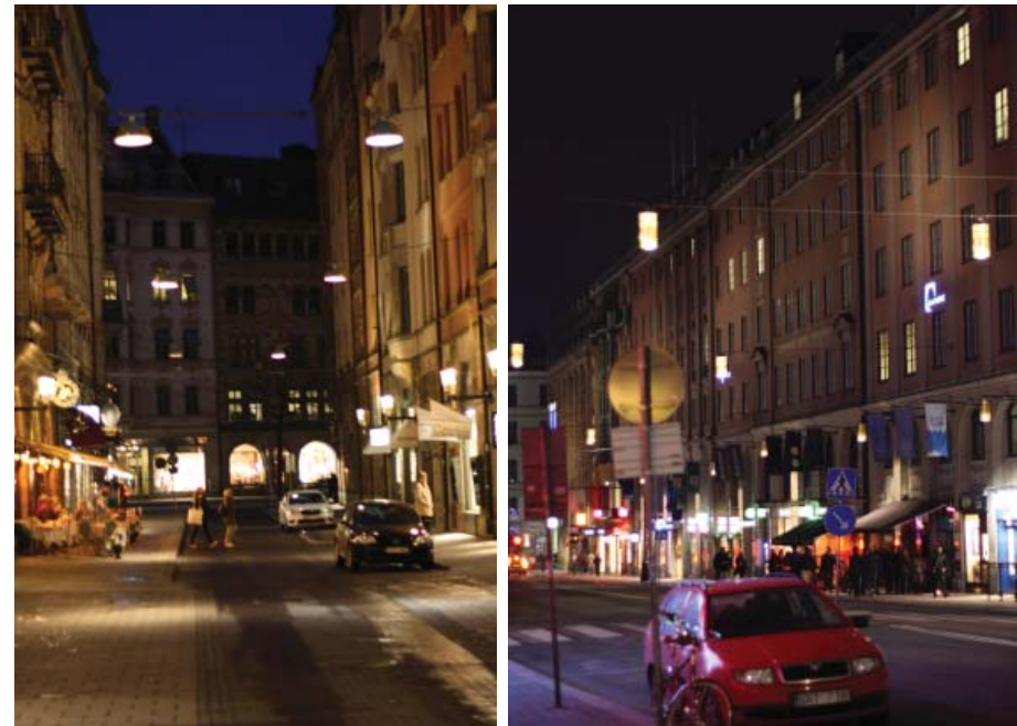
Biblioteksgatan och Kungsgatan, Stockholm. Exempel på belysning som är utformad utifrån en helhetssyn.
