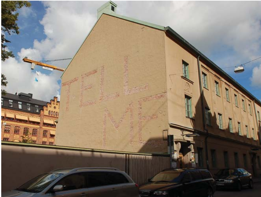
Bilden ovan visar muren mot gården i kv. Klostret vid Gamla gatan.
