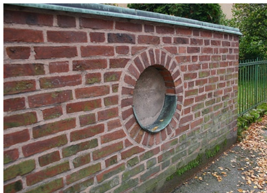
Denna tegelmur ligger i ett starkt trafikerat hörn i centrala Örebro. Huvudbyggnadens fasad består av likadant tegel. Bygglov krävdes redan när den byggdes.
