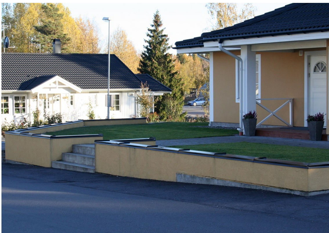
Denna låga stödmur, mycket väl anpassad till huvudbyggnadens och till kvarterets moderna karaktär, är bygglovspliktig. Det är höjden från den lägsta marknivån som räknas.
