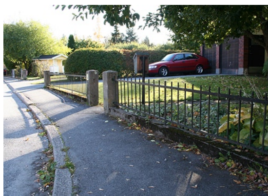
Välj material av hög kvalitet och var noga med att få det hela rakt och stabilt. Då kommer ditt staket eller din mur att hålla lika länge som detta.
