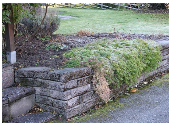
Stödmurar som tar upp nivåskillnader i marken kräver inte bygglov om de är lägre än 0,5 meter.
