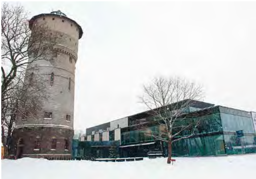
Södra vattentornets moderna tillbyggnad fick årets byggnadspris.
