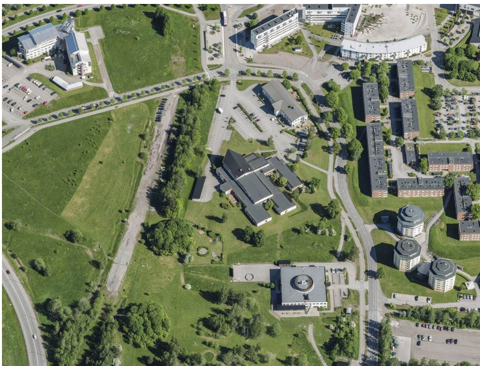
Bilden visar befintlig bebyggelse inom och intill planområdet.
