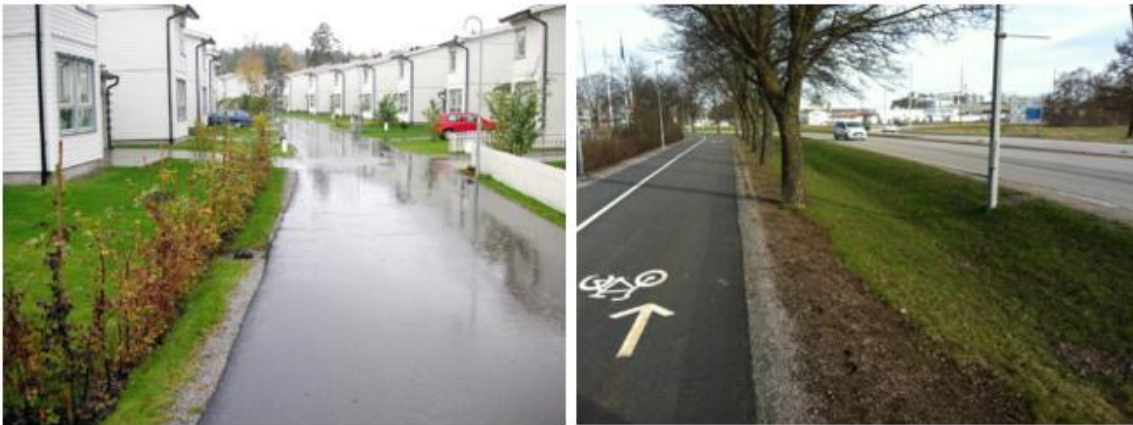
Figur 1. Exempel på makadamdike mellan lokalgata och tomtmark (t.v). Exempel på svackdike mellan väg och cykelbana (t.h). (Foton: WRS)
