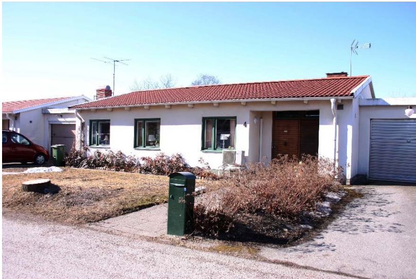
Kedjehus från tidigt 1960-tal på Mantalsgatan Sörby
