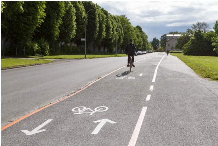
Figur 5. Utformning av huvudcykelstråk (Orange kantlinje samt vit separeringslinje mellan gång och cykel)
