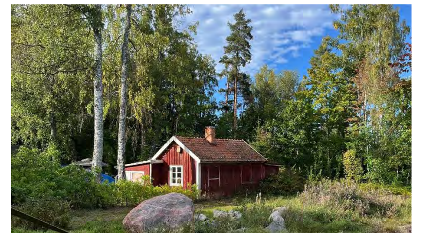
Mindre torpstuga, troligen från tidigt 1800-tal med ursprunglig form och volym.
