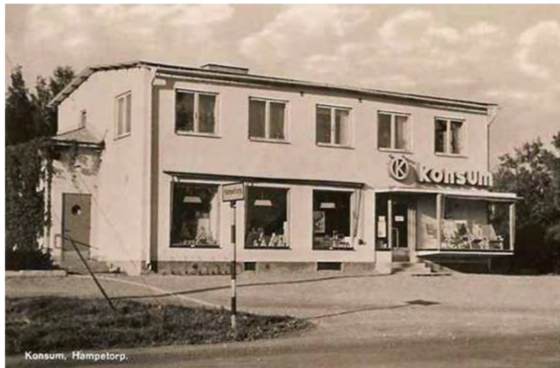
Konsumbutiken, uppförd 1940 på platsen där den tidigare handelsboden stod. Efter konsum fanns här en tid en kopparslagare och en pizzeria. Idag finns byggnadens grund kvar. Foto www.lannas.se
