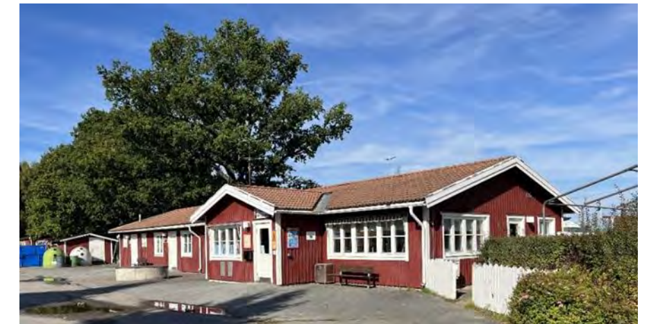
Campinganläggningens huvudbyggnad med restaurang, byggd under 1980-talet utgör i viss mån en symbol för Hampetorps identitet som sommarort
