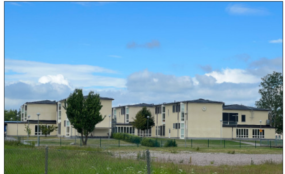
Rostaskolan är liksom Rosta stjärnhusområde ritad av arkitektduon Backström och Reinius. Enhetligt lågmäld skala och slätputsen med dess ljusa färgsättning signalerar en lätthet. Öppenheten och den låga skalan i bebyggelsen är väsentlig för slättlandskapets karaktär.
