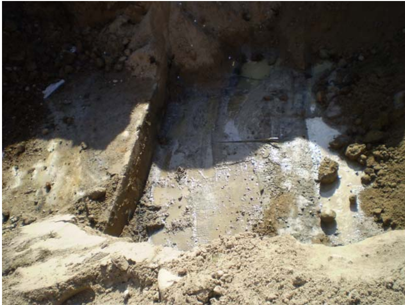
Foto 4.4. Fotot illustrerar de två betongplattor som lämnats kvar i mark.
