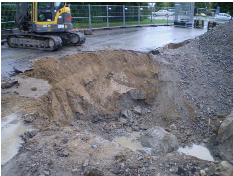
Foto 4.2. Vy mot sydost. Schakt i Tomtebogatan.
