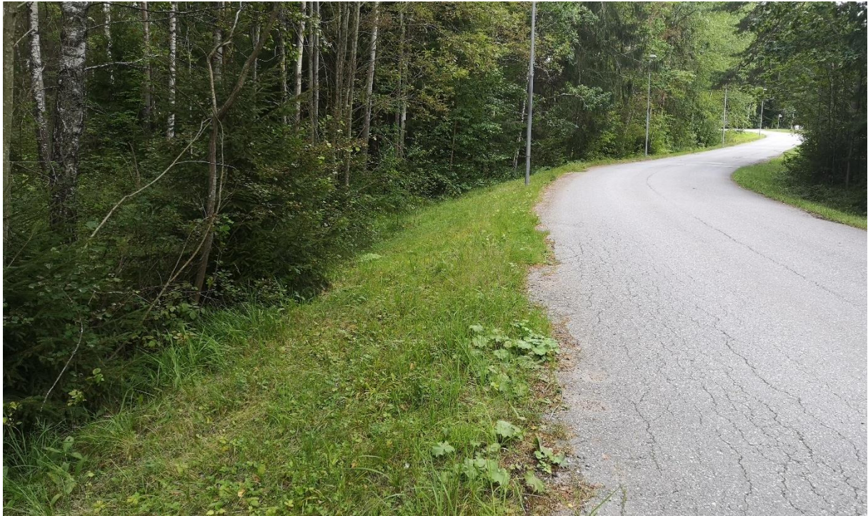
Figur 24. Läge D, Sanatorievägen, sett från väster.
