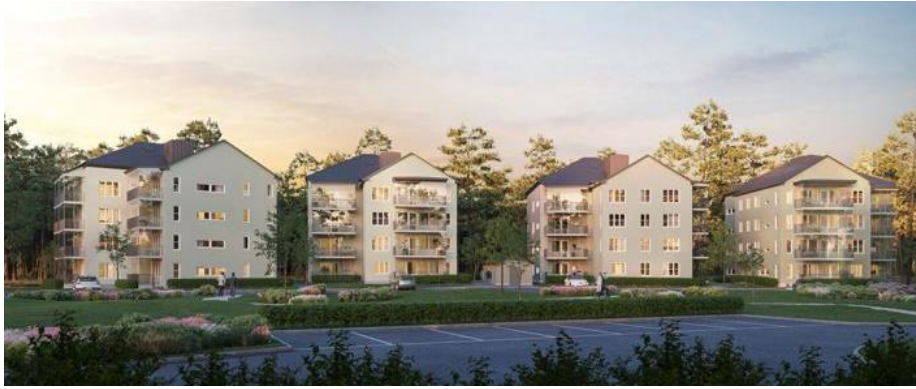
Figur 6. Nybyggnation Sanatorieskogen (Lejons mäklari, 2021)
