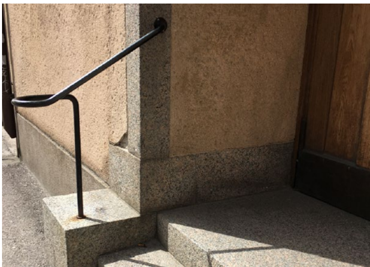
Vid kyrkans entré finns ursprungliga material som trappsteg i granit och räcke i svartmålat smide
