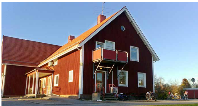
Viagården i Vintrosa har bytt golvmattor med hjälp av bidrag från Landsbygdsnämnden. Foto: Anders Holm
