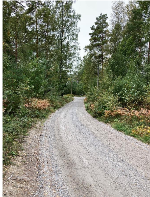
Figur 18. Läge H. Kraftig lutning på Fäbrovägen innan höjdbildningen i mitten av planområdet.
