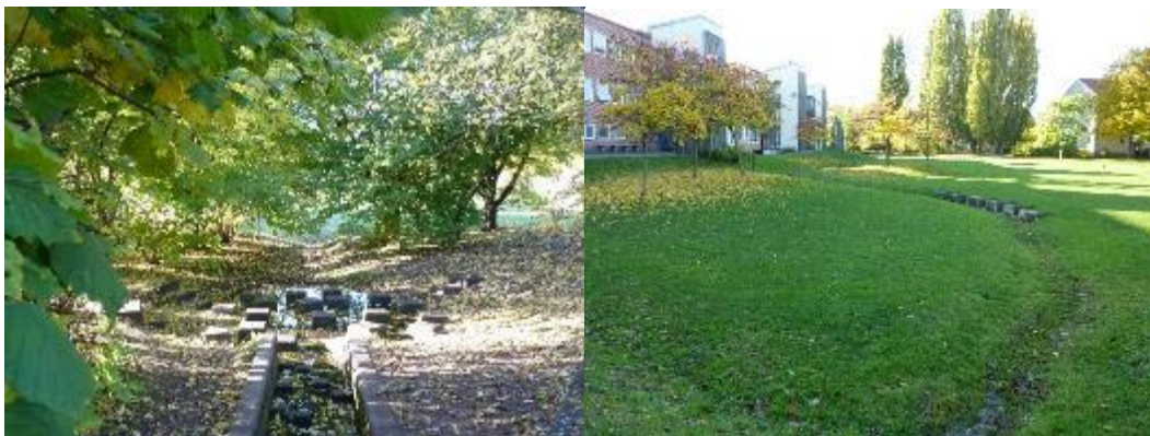
Figur 18. Exempel på utformning av en torr damm/översvämningssbar yta. Foto: WRS.
