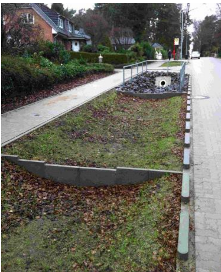
Figur 21. Exempel på svackdike med dämme, foto WRS.
