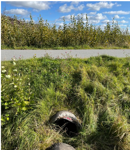
Bild 3 - Inlopp till vägtrumma under GC-vägen (Eget foto)
