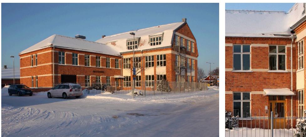
I bild ovan syns den före detta skofabrik som är lokaliserad precis norr om planområdet.
