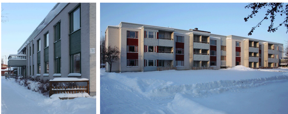
Bilderna visar de mot planområdet närmast angränsande delarna av Rostahemmet, uppförda under 1970-talet.
