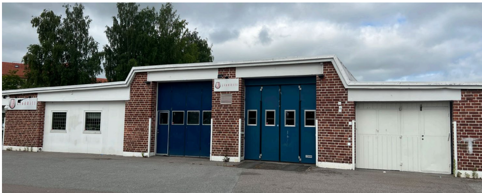
Den befintliga garagebyggnaden inom fastigheten, sett från öster.
