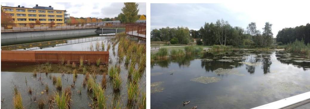
Två olika våta dammar, den vänstra har en vägg mellan olika delar av dammen för att öka retenstionstiden samt är djup i början för sedimentering för att sedan bli grundare (Våtmarkszon). Foto: Tyréns
