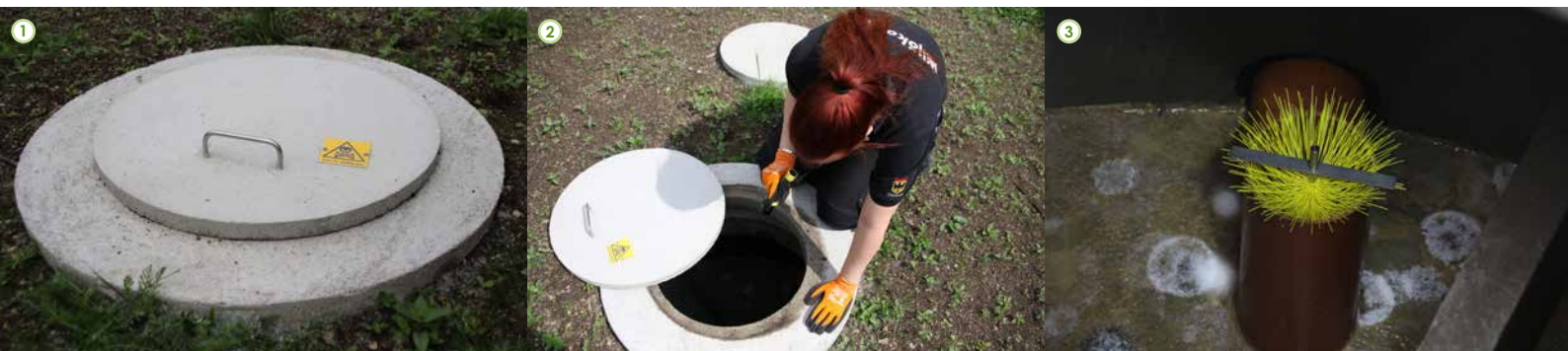
Bilder från en avloppsinspektion: 1) En slamavskiljare. Locket är ganska litet och har ett handtag vilket är smidigt vid öppning. 2) Bodil kontrollerar att slamavskiljaren är hel och ren. 3) Bilden visar ett t-rör och en borste. 4) Kontroll av fördelningsbrunnen. Den ska vara tät och vattenytan ska ligga i nivå med den nedersta kanten av utloppet. 5) Luftningsrören på bädden kontrolleras. Att de är hela, tillräckligt höga för att inte bli begravnade i snö, att det finns ett ventilerande lock, att de ser rena ut på insidan och att det inte står högt med vatten och/eller slam i rören.
