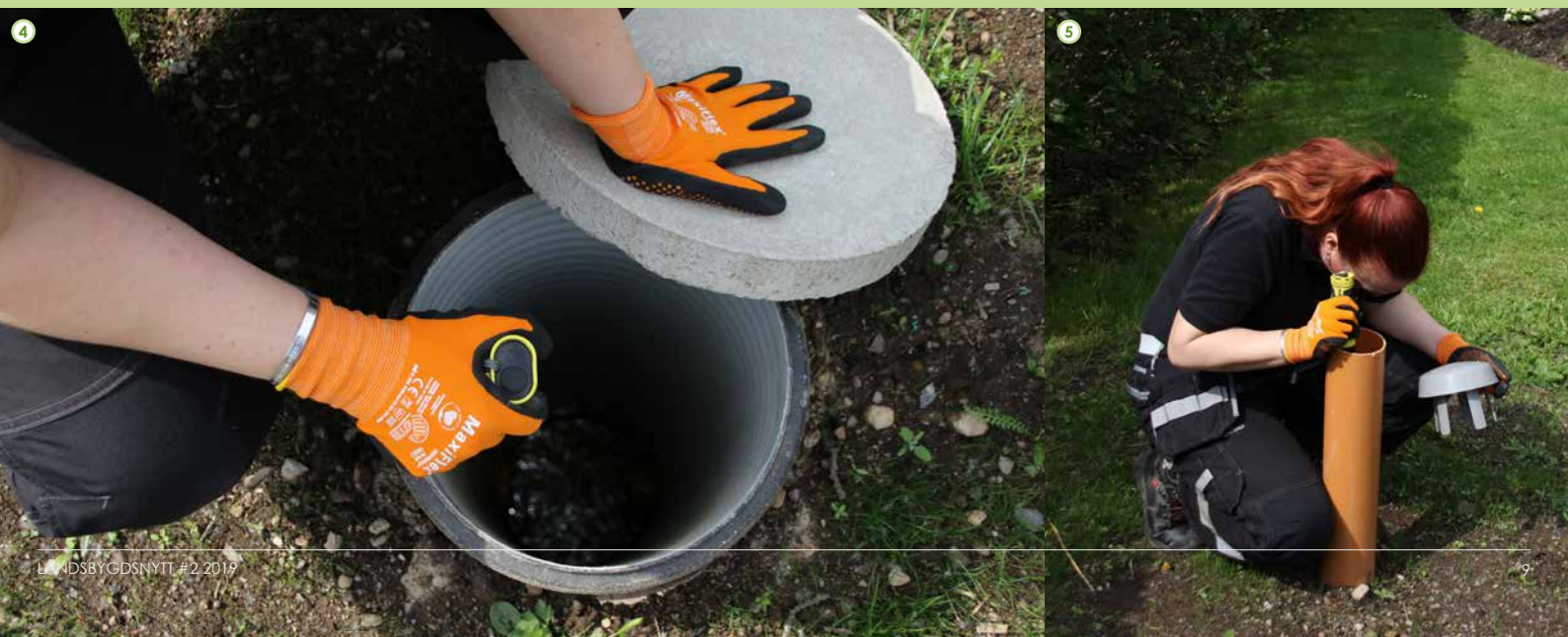
Bilder från en avloppsinspektion: 1) En slamavskiljare. Locket är ganska litet och har ett handtag vilket är smidigt vid öppning. 2) Bodil kontrollerar att slamavskiljaren är hel och ren. 3) Bilden visar ett t-rör och en borste. 4) Kontroll av fördelningsbrunnen. Den ska vara tät och vattenytan ska ligga i nivå med den nedersta kanten av utloppet. 5) Luftningsrören på bädden kontrolleras. Att de är hela, tillräckligt höga för att inte bli begravnade i snö, att det finns ett ventilerande lock, att de ser rena ut på insidan och att det inte står högt med vatten och/eller slam i rören.
