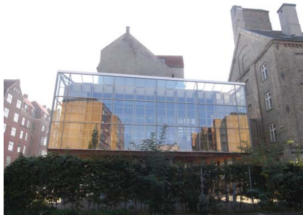
Ny tillbyggnad i glas, Köpenhamn. Foto: Ida Westergren, Sweco
