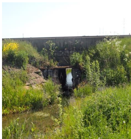
Figur 6 Trumma under spår 2 och 3.
