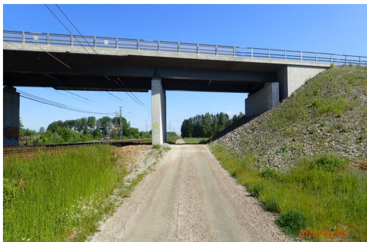
Figur 29 Vägbro över järnvägen.
