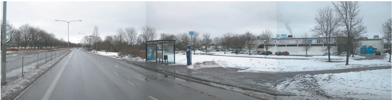
Karlslundsgatans busshållplats i höjd med Haga centrum. Haga centrums fasad mot gatan syns till höger.
