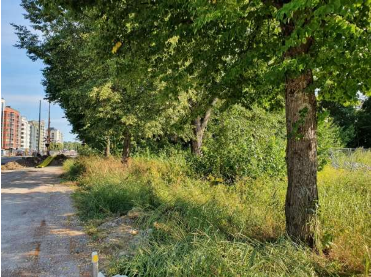
Figur 5. Grävning nära träden.
