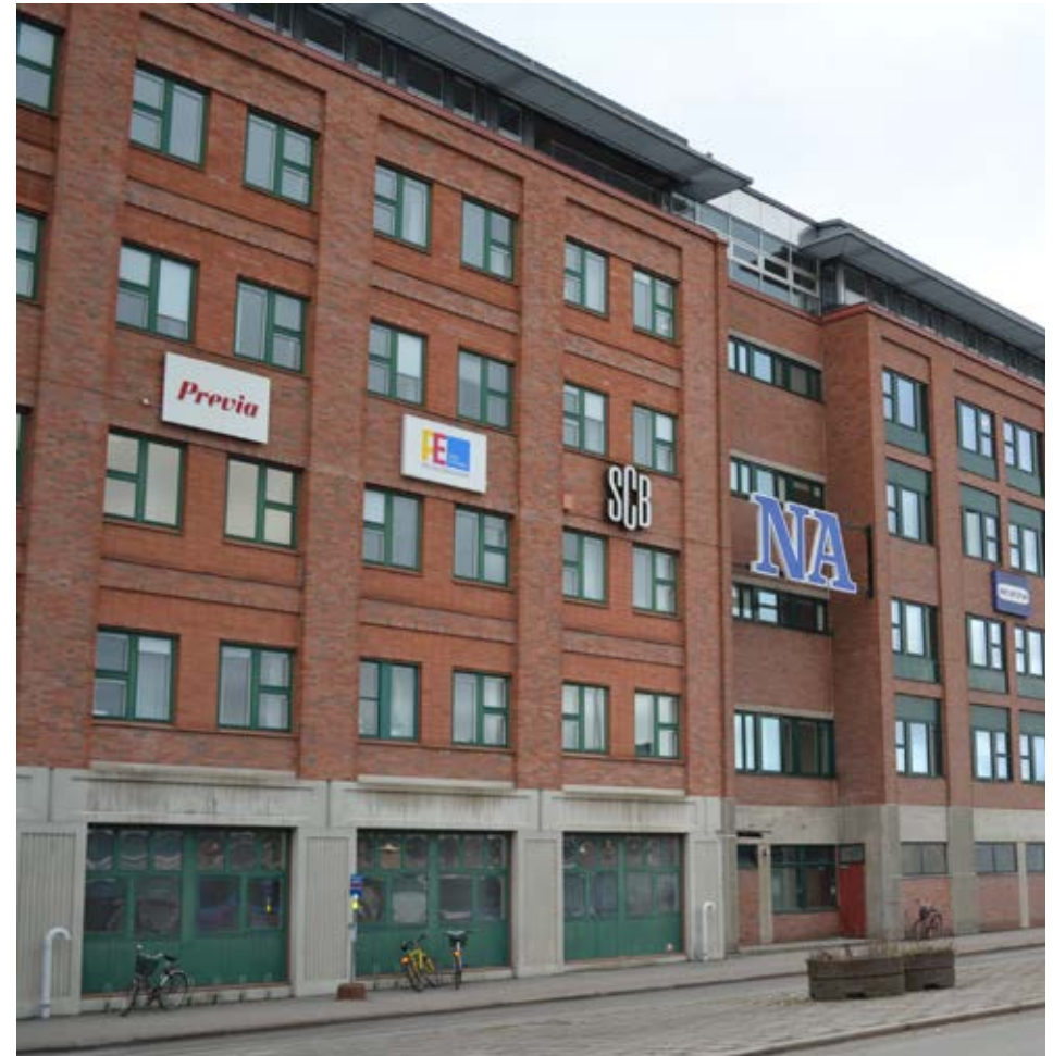
SCB-huset från Östra Bangatan. T.h i bild ursprungsbyggnaden från 1976 med bröstningar i grön aluminiumplåt. T.v. i bild påbyggnaden från 1990-talet med bröstningar i flatmurat tegel.
