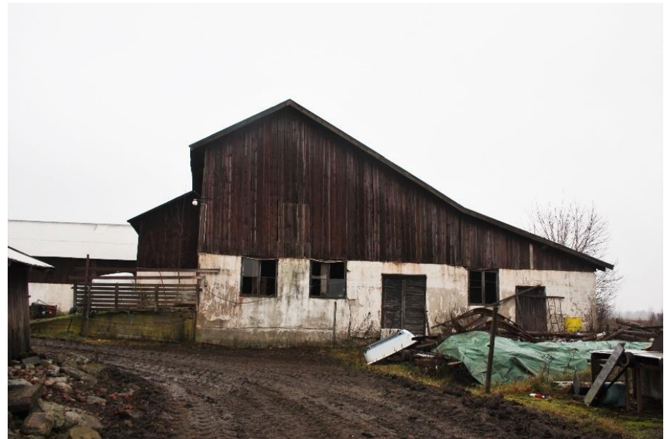
(Byggnad 2) Ladugården sett från gårdsplanen (längst upp), och från syd (ovan).
