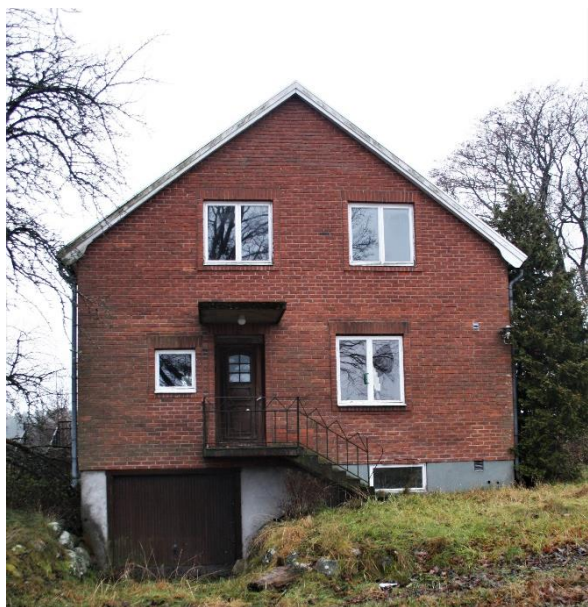
(Byggnad 1) Östra fasaden.
