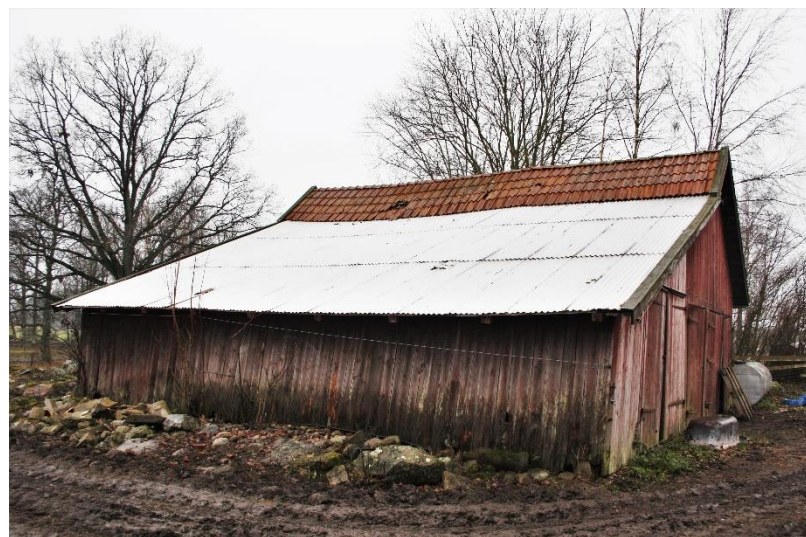
(Byggnad 4) Uthus nr 2 fotograferat från norr och öst. Tillbyggnaden utmärks tydligt mot den först uppförda byggnadsdelen.
