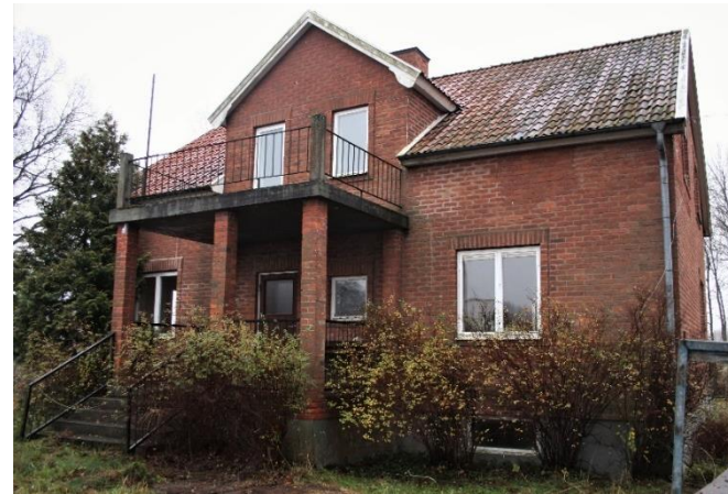
(Byggnad 1) Mangårdsbyggnadens huvudentré med öppen farstuvist där tre pelare i tegel håller upp den ovan- liggande balkongen.
