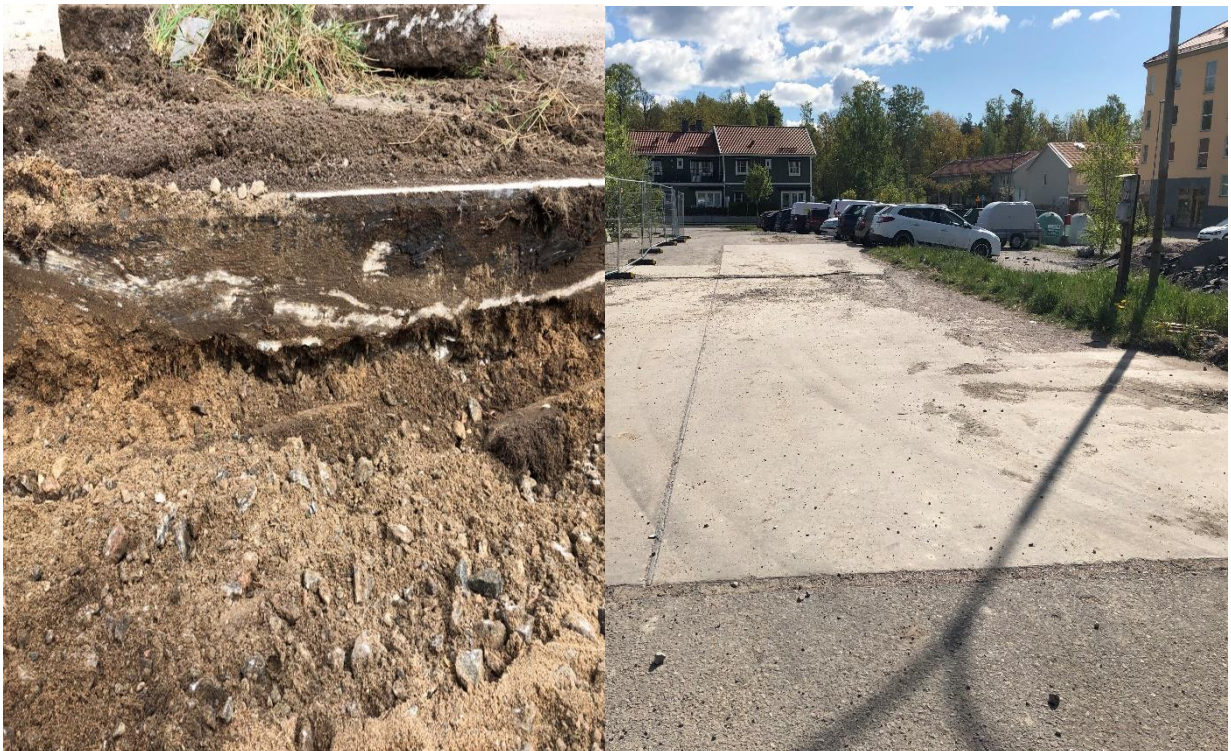
Figur 6.1. Påträffad betongplatta vid provgrop SM2.
