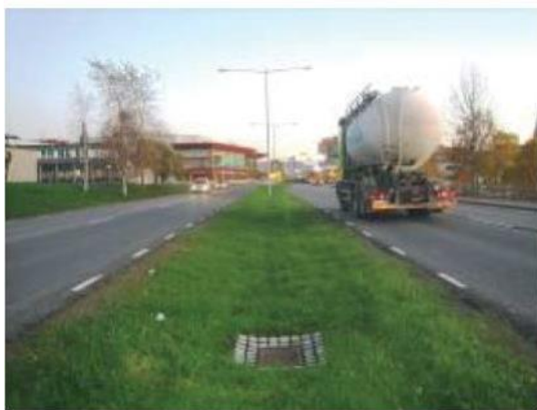
Figur 27. Två exempel på svackdiken. (Svenskt Vatten Utveckling, 2016)
