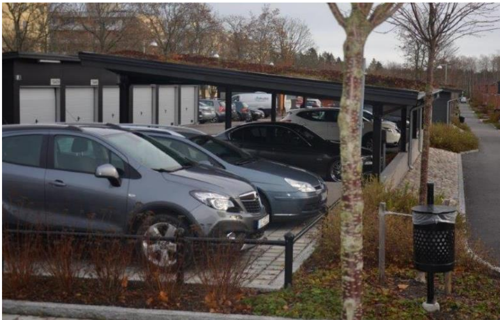
Figur 7. Ombyggda parkeringsplatser längs Gransrisvägen med genomsläpplig beläggning, gröna tak och öppna stuprör. Foto: WRS 2019-10-30.
