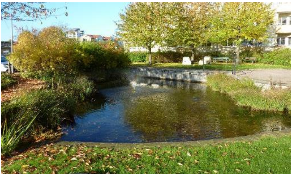
Figur 17. Exempel på utformning av damm för uppsamling av dagvatten. Augustenborg, Malmö. Foto: WRS.
