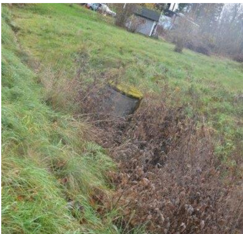
Figur 13. Dike och brunn där vattnet från lågpunkten avleds till ledning och vidare till dike vid Gällerstavägen. Foto: WRS 2019-10-30
