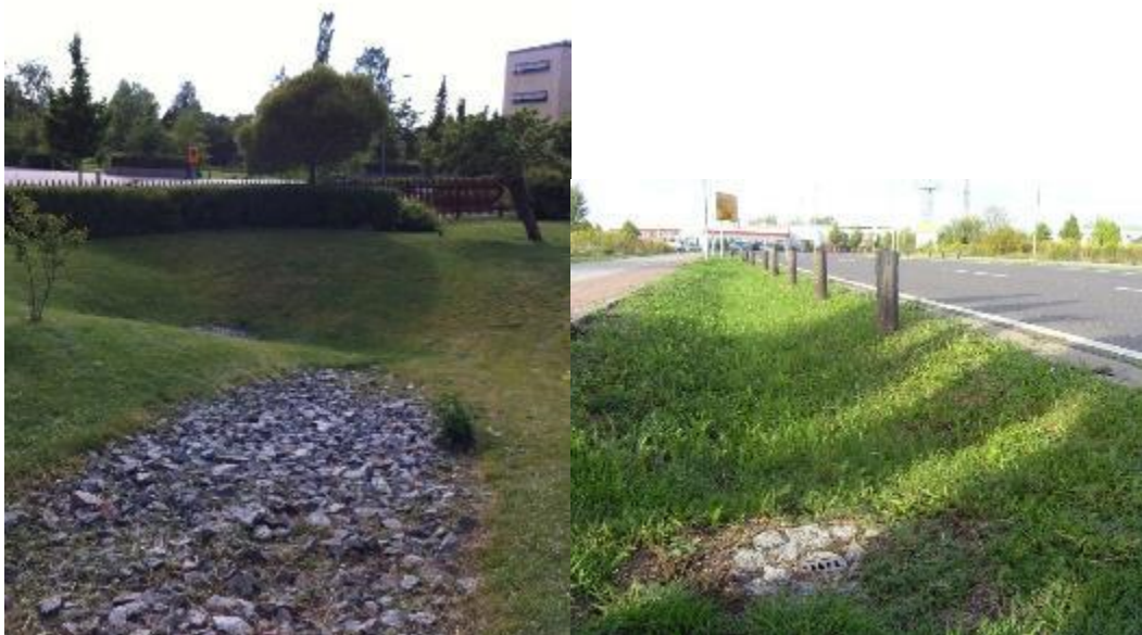
Figur 20. T.v. Exempel på enkel utformning av delvis gräsbeklätt makadamdike som tar emot dagvatten från väg och översilningsyta. T.h.: Exempel på infiltrationsstråk som tar emot dagvatten från väg och gc-väg. Foto: WRS.
